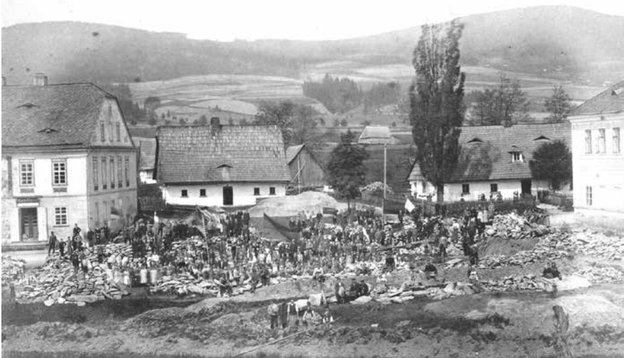
Baubeginn des Gebäudes der Bürgerschule (1872). Das ursprüngliche städtische Schulgebäude befindet sich am rechten Bildrand.
